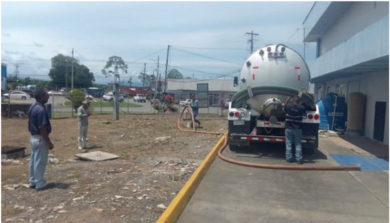
Limpeza del Tanque Séptico para evitar desbordes de aguas servidas en los baños de la Terminal.
